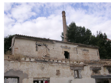
Molí de Vernís. Segle XV. Manises PRÒXIMA DEMOLICIÓ.
